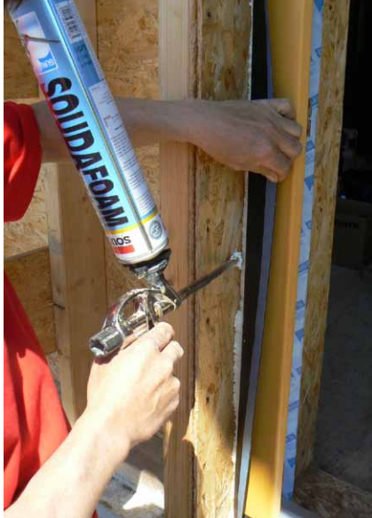
Správně zabudované okno s uzavřenou přípojovací spárou v dřevostavbě a ve zděné stavbě (foto: Slavona)
