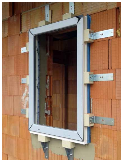
Ukázka předřazené montáže okna pomocí systému DAFE PUREX (foto: DAFE-PLAST)
