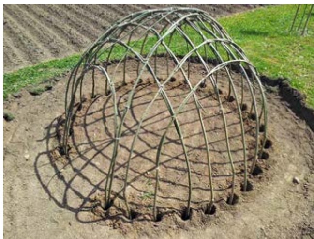
Základ živých staveb tvoří 50 cm hluboké do země vyvrtané díry, které se po zasazení prutů zasypou zeminou...
